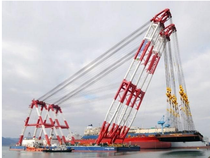
Figuur 21: Hyundai 10000, de grootste floating crane ter wereld.
